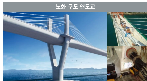
공사기간 : '11.12~'17.06 교량형식 : 2면 2주탑 ExtraDosed교 | 교량규모 : L=360m, 왕복2차로
