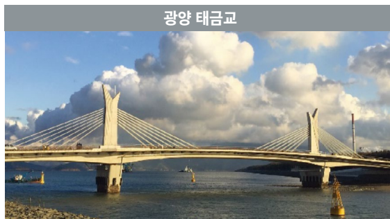
공사기간 : '12.08~'15.12 교량형식 : 1면 2주탑 ExtraDosed교 | 교량규모 : L=215m, 왕복4차로
