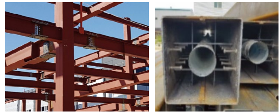
내부 강관에 콘크리트 타설로 내외부 강관전체 충전가능
